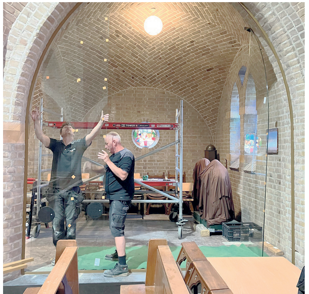
Plaatsen van glaswand.
